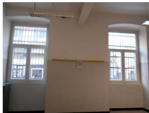
Figura 8.5 - Particolare di un infisso
