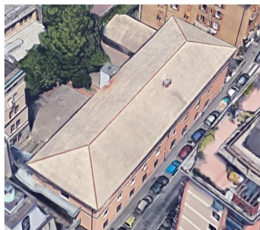
Figura 8.11 - Particolare della copertura dove installare l’impianto (fonte: Google Earth)
