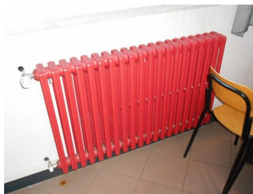
Figura 4.10 - Particolare valvole termostatiche installate sui radiatori
