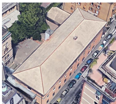
Figura 8.3 - Particolare della copertura
