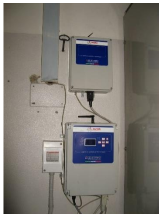
Figura 4.11 - Particolare della centralina di controllo Figura 4.12 – Dispositivi per la telegestione dell’edificio
