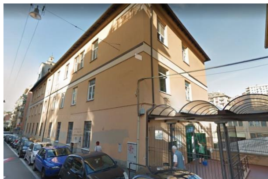
Figura 0.1 - Vista della facciata [esposta a Sud-Ovest]
