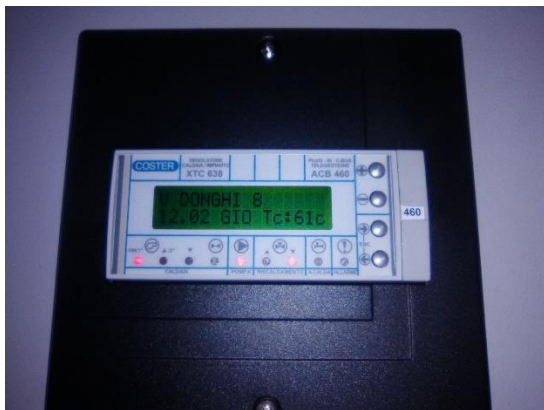
Figura 4.11 - Particolare della centralina di controllo Figura 4.12 – Dispositivi per la telegestione dell’edificio
